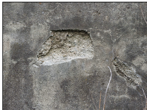
foto č. 9: PKO02 střed - degradovaný beton
