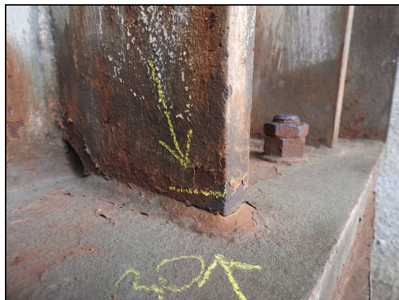
foto č. 4: K 01 L. HL. N. vně nad O 01 svislá výztuha - trhlina
