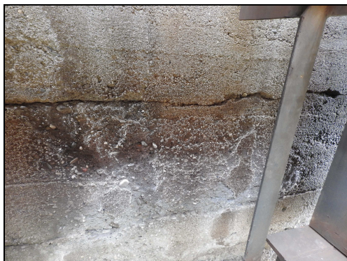
foto č. 7: O 02 závěrná zeď střed - trhlina
