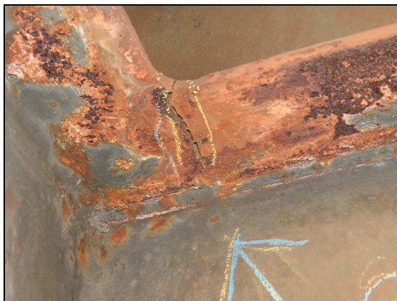
foto č. 3: K 01 P. HL. N. připojení k 5. PŘ. v 4. poli - trhlina
