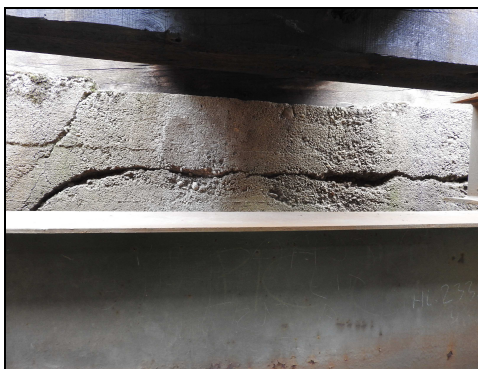
foto č. 6: O 01 závěrná zeď střed - trhlina
