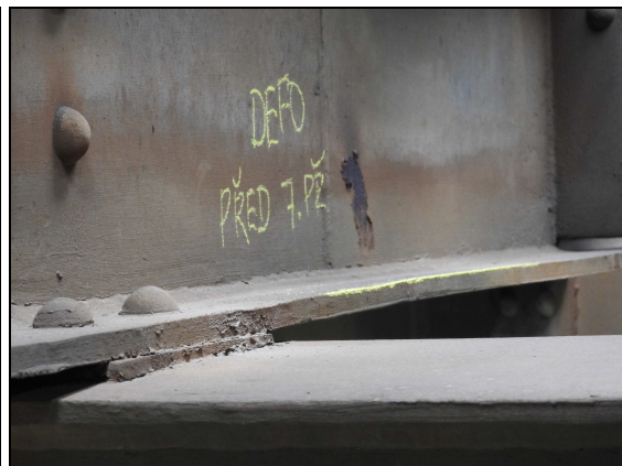
foto č. 2: K 01 P. PODÉL. 6. pole před 7. PŘ. - deformace
