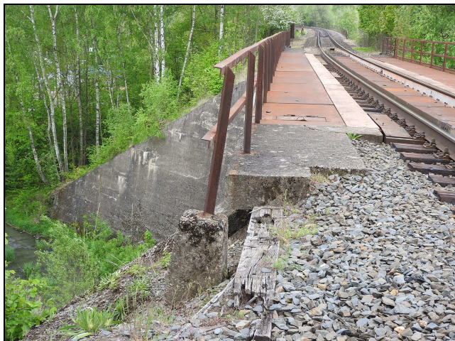
foto č. 11: zábradlí vpravo konec - volná betonová patka
