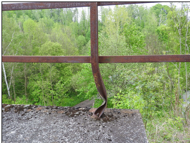
foto č. 10: zábradlí vpravo na začátku 5. sloupek - deformace
