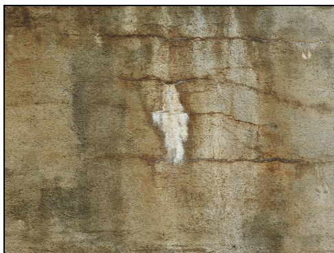
foto č. 5: O 01 střed - trhlina s výluhy pojiva
